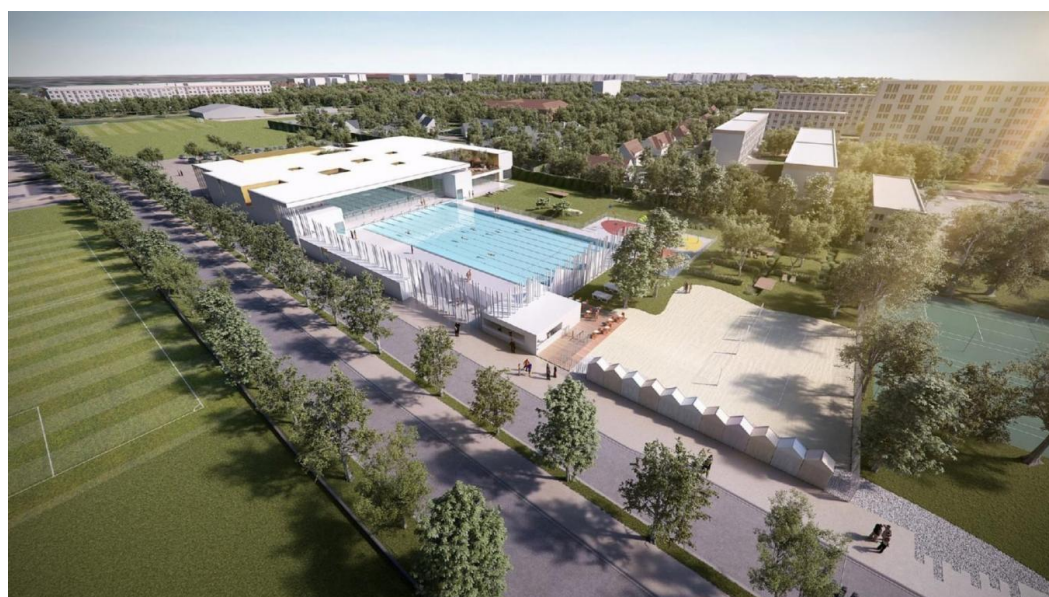
Le futur centre sportif Aquapole, rue Alexandre Dumas
